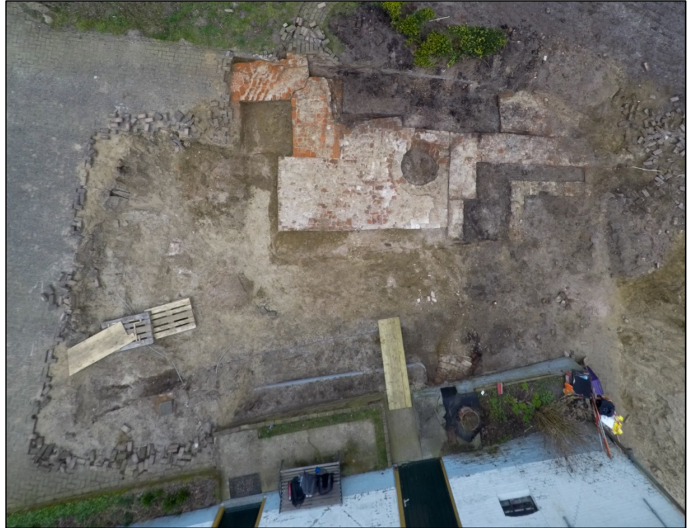
Afb. 3.1 Luchtfoto van het aangetroffen, schoongemaakte muurwerk (d.d. 21-03-2016). De bovenkant van de foto wijst naar het noordwesten.
