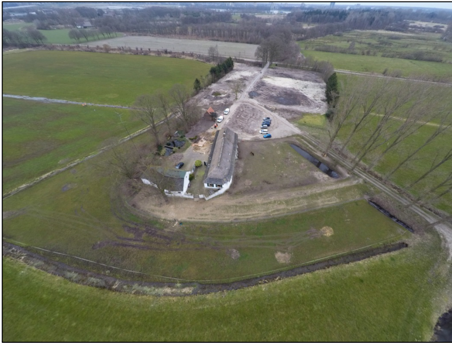
Afbeelding 3.4 Zicht op het plangebied gezien vanuit het zuiden (d.d. 21-03-2016). Op de achtergrond een braakliggend terrein waar voorheen stallen hebben gestaan.
